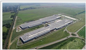
Photovoltaik-Anlage auf den Dächern der beiden Logistik-Hallen von Audi Hungaria.
