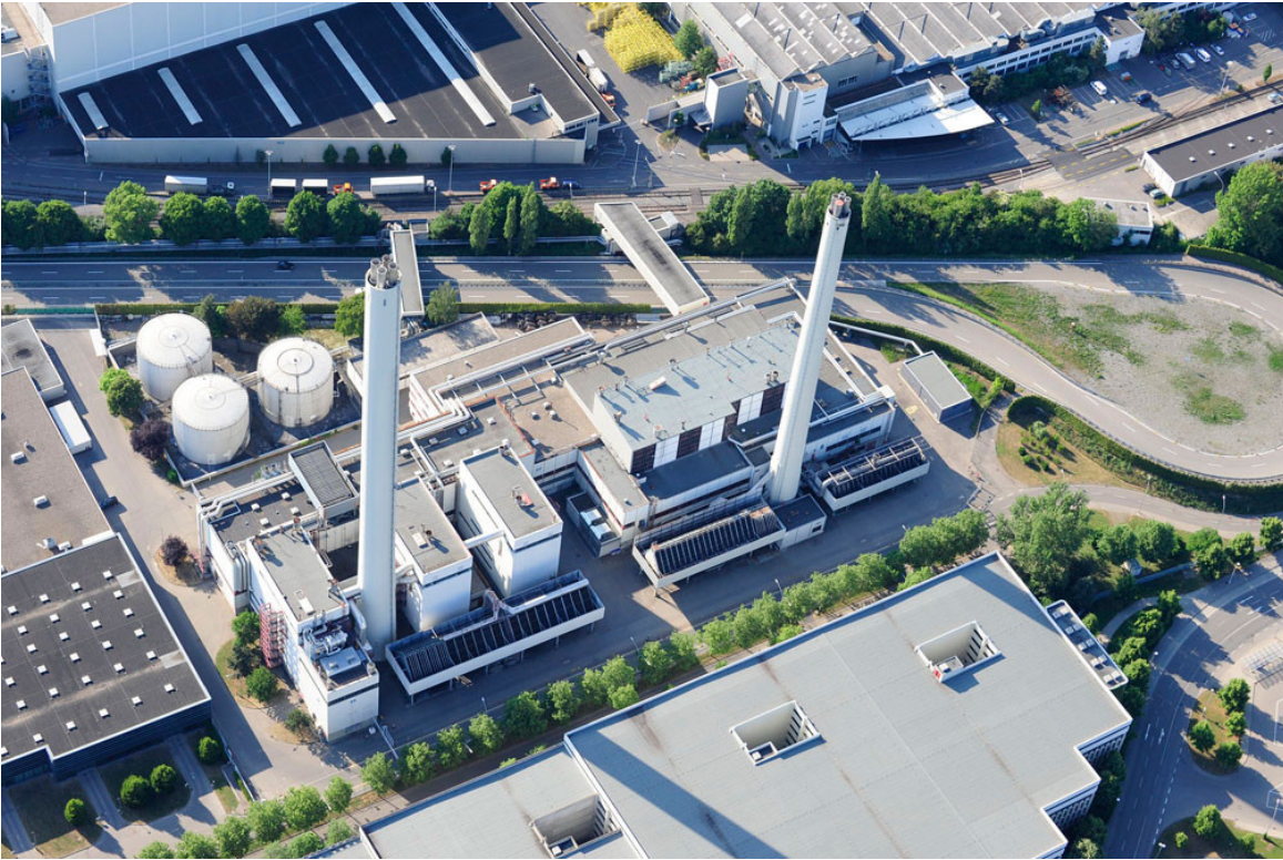
Heizkraftwerk am Mercedes-Benz Standort Sindelfingen.
