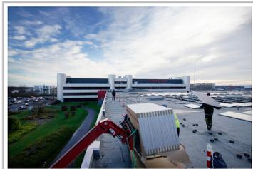
Bau des Solardachs am Standort von Toyota Deutschland in Köln: Anlieferung der Module.
